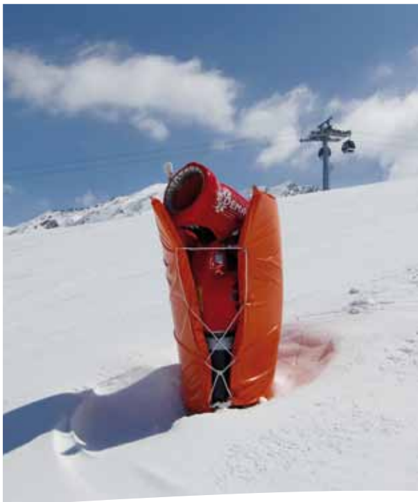
Tekniske installasjoner i nedfartene må polstres forsvarlig.
