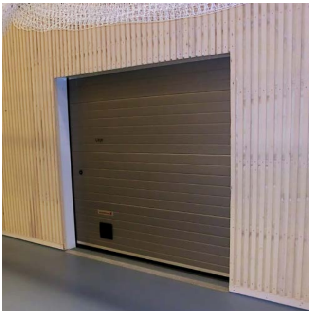
Port til lagerrom. Foto: Morten Roa
