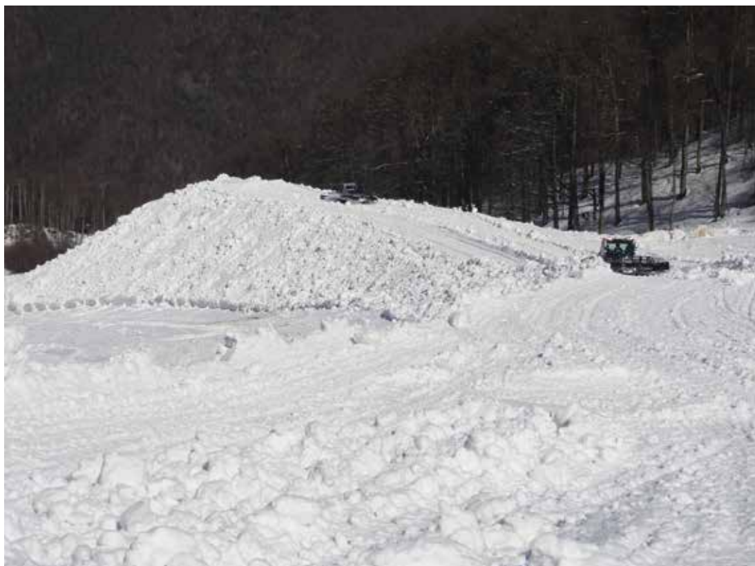
Snø samles i diger haug for senere å dekkes med flis eller spesial tekstil. Snøen må være homogen og ha tetthet mer enn 0,7kg per liter.
