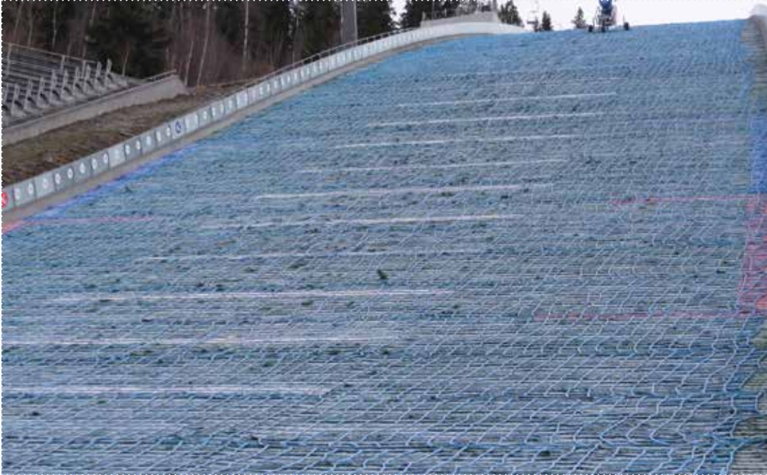
Nett som legges opp på plastdekket for å hindre snøen fra å skli nedover.
