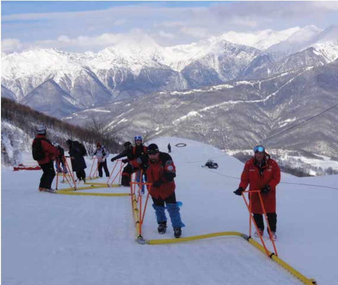
Mannskap i gang med injisering av vann under trykk ned i ferdig preparert renntrasé. Dette gir en tykk, tett og homogen såle av snø før lang tids bruk.
