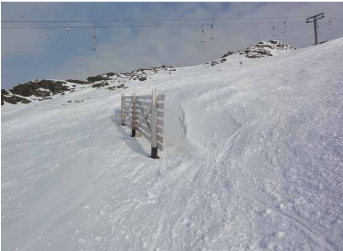
Et riktig bygd og plassert snøgjerde er den rimeligste metoden for å sikre snø i mange områder over tregrensen.
