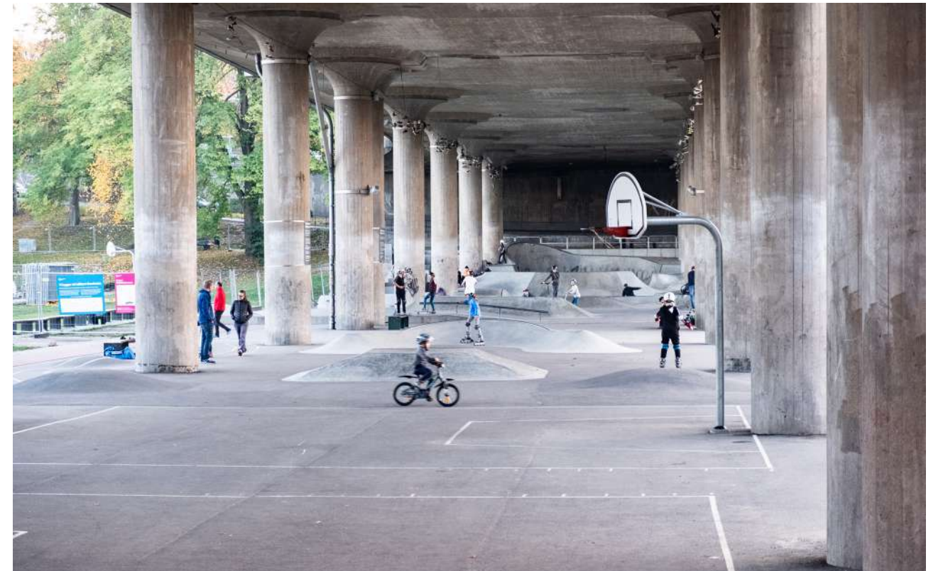
Utrymmet under bron i Rålambshovsparken utnyttjas till skatepark och blir på så vis en plats man kan komma till och åka året om.
