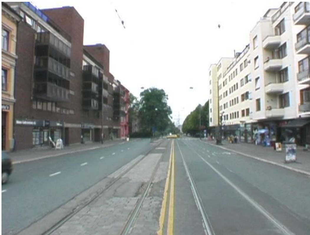
Figur 32: Ring 2 (Kirkeveien) i Oslo. Foto: Statens vegvesen
