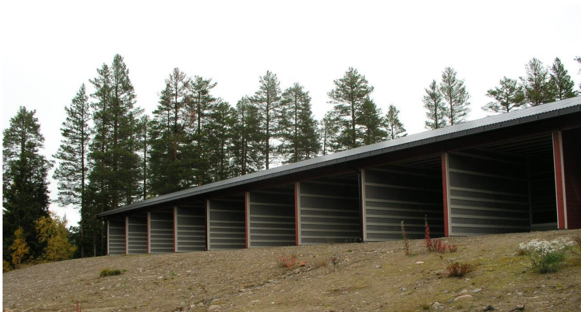
Figur 55. Nytt støydempet standplassoverbygg, Nybergsund skytebane. Foto: DFS
