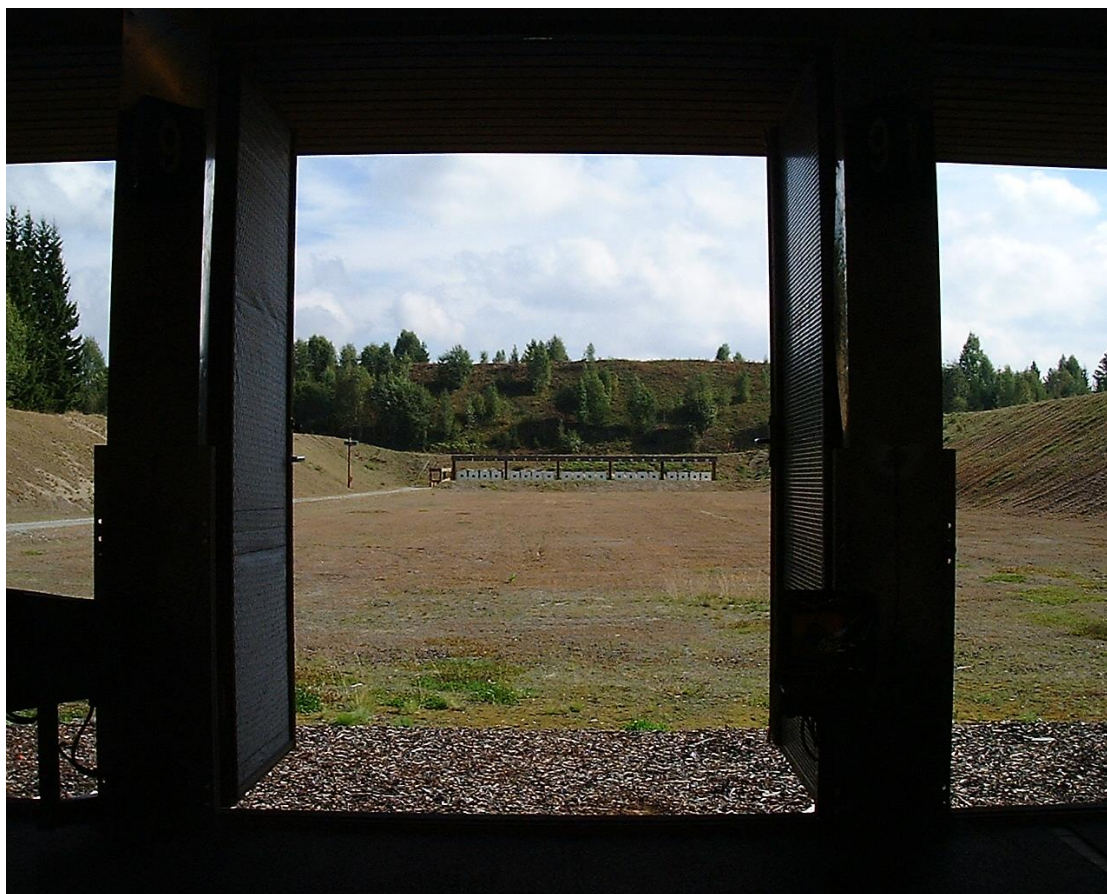
Figur 57. Eksempel på en bane med omfattende støytiltak: Overbygd standplass med frambygde, absorbentkleddte båsvegger og høye støyvoller. Bildet er fra Bane 17 på Sessvollmoen. Foto: Forsvarsbygg
