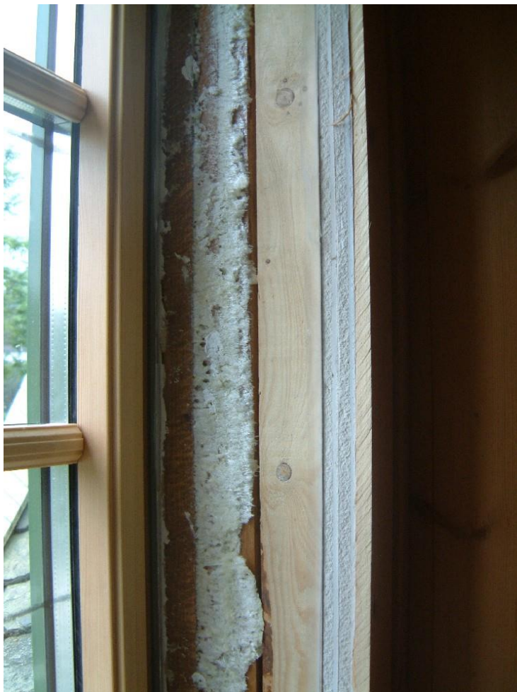
Figur 20. Ekstra lydisolering av eldre hus er ofte nødvendig for å tilfredsstille krav til innendørs lydnivå ved nye vegprosjekter. Her et eksempel med nye vinduer og bruk av doble gipsplater innenfor panel. Foto: Statens vegvesen
