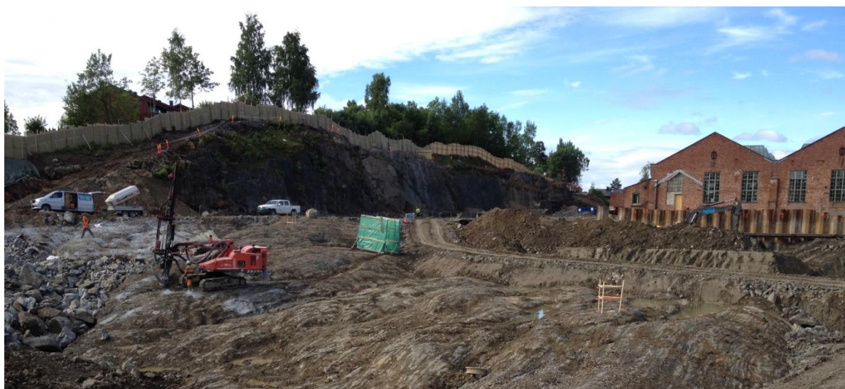
Figur 26: Midlertidig støyskjerm/byggeplassikring plassert på toppen av fjellskjæring. Foto: Brekke & Strand Akustikk AS.
