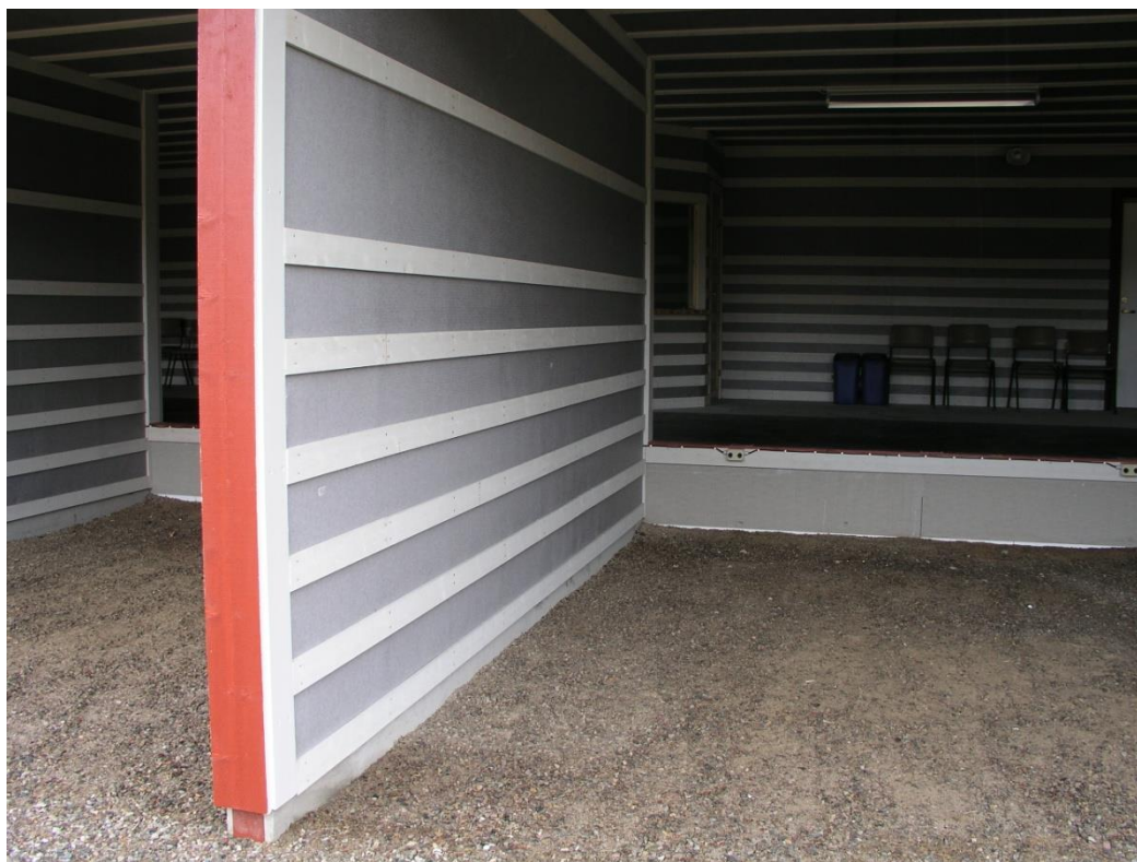
Figur 58: Moderne standplassoverbygg har frambygde absorbertkledd båsvegger som demper støyen betydelig
