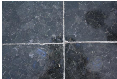
38:Skjøter i dekket. Foto CD
