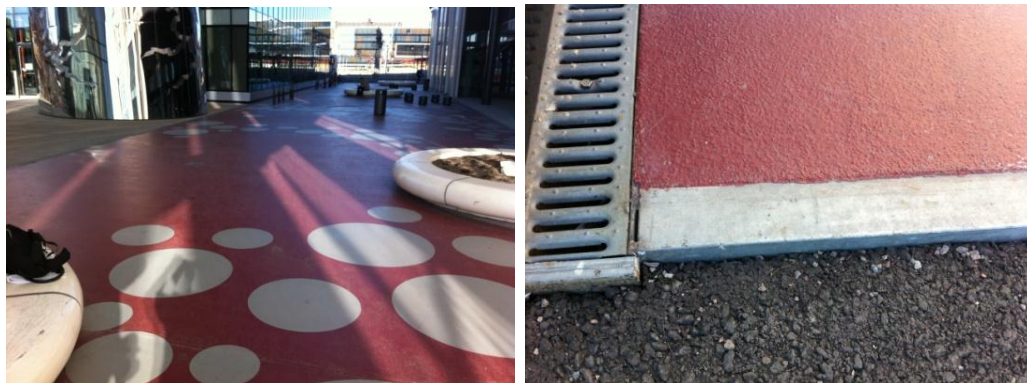
50-51: Flowcrete Norway har etablert dette polyuretandekket i Oslo, NB!men dette har sklisikring. Området ligger ved Barcode vis a vis Operaen, mellom KLP- og PWC-byggene. Foto: CD
