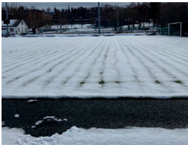
Foto 9 Undervarmanlegg driftet for snøfjerning (Sandvik, Myhr 2021)
