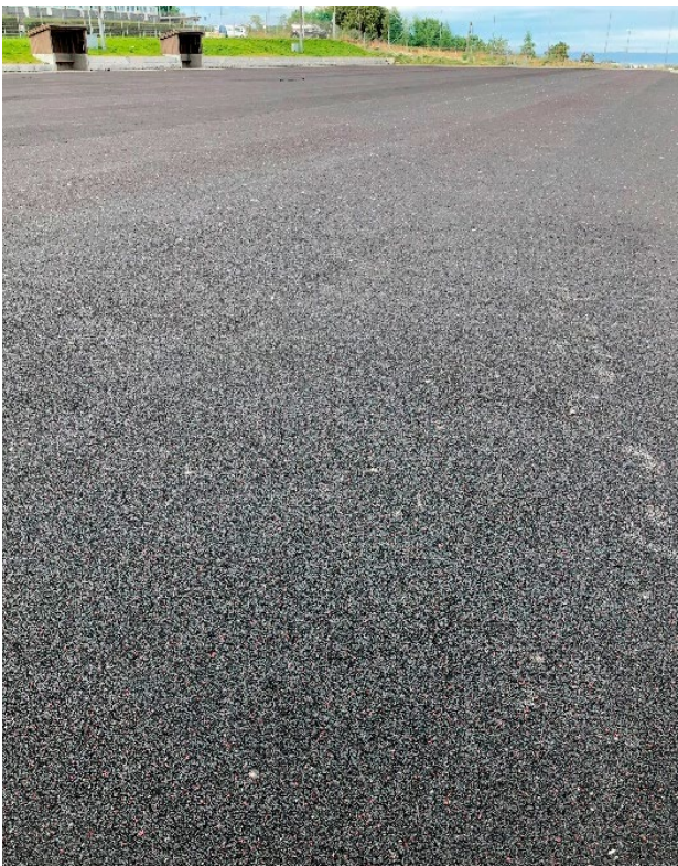
Foto 1 E-layer Flatås 11-er. Materialet er resirkulert EPDM fra bilindustrien
