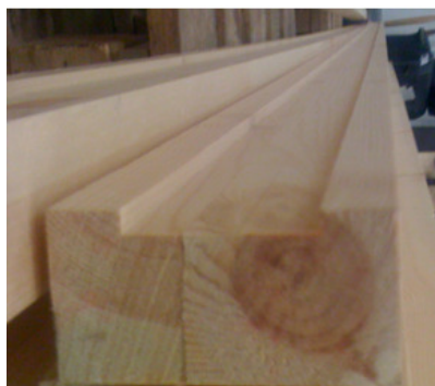
Figur 13: Lekt med innfelt sone for dempningsmateriale
