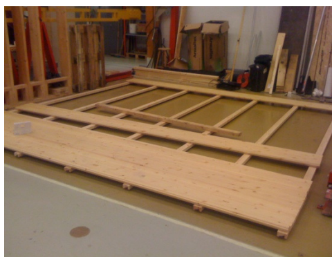
Figur 18: Legging av gulv
