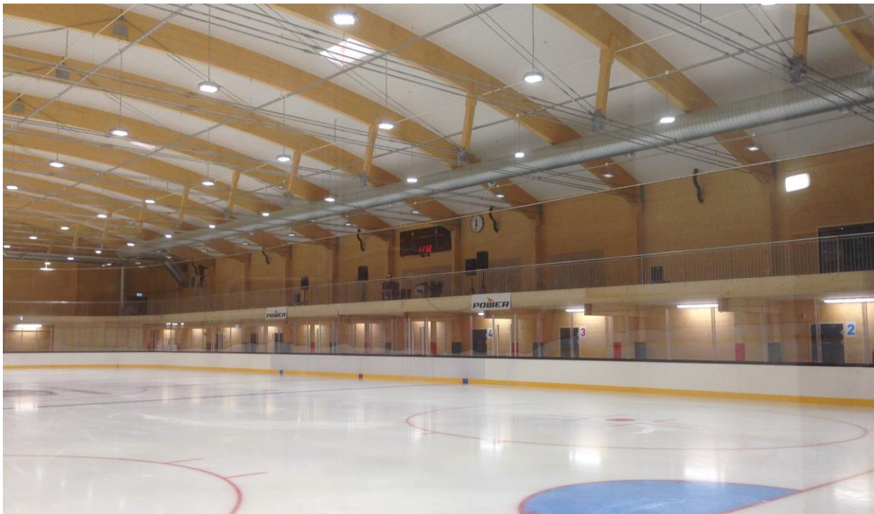
Figur 4: Mot langsiden med mesanin, tilførsel av friskluft på denne siden
