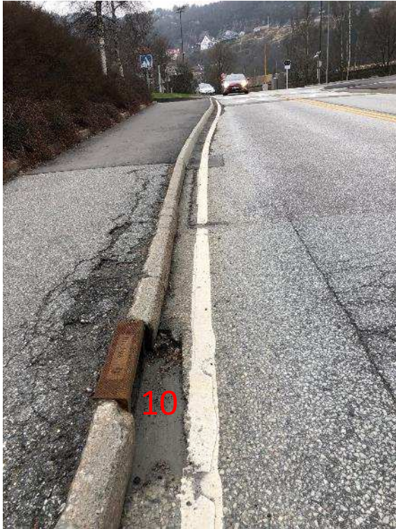
Stemmen 10, nedløp ved kjeftesluk nedenfor overgang og busstopp
