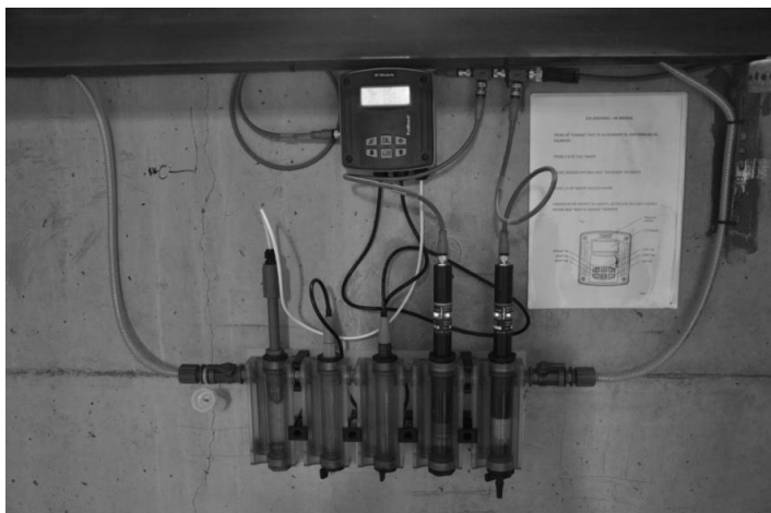
Figur 6: Bildet viser den automatiserte webanalysen ved Husebybadet
