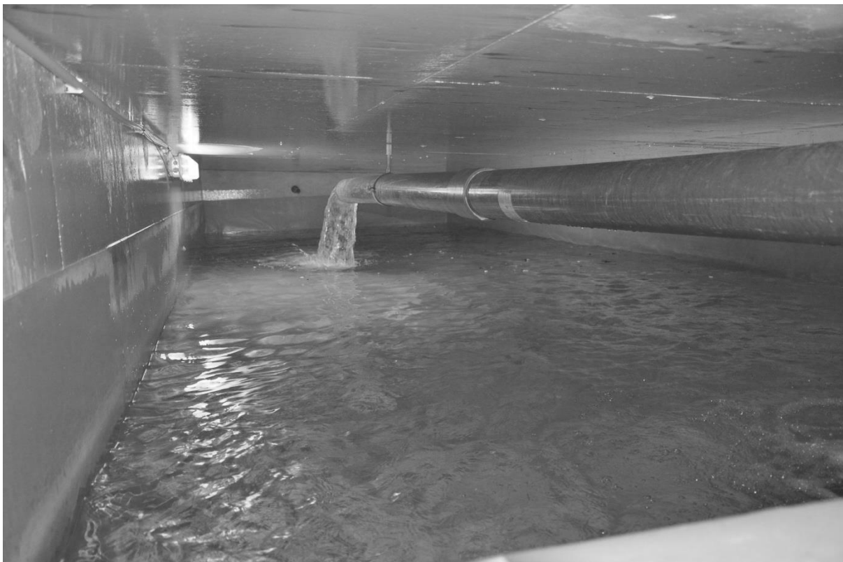
Figur 2: Bildet viser et utjevningsbasseng tilhørende Husebybadets treningsbasseng.
