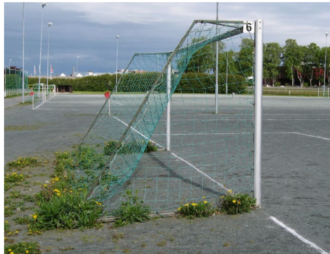
Manglende vedlikehold kan føre til skader
