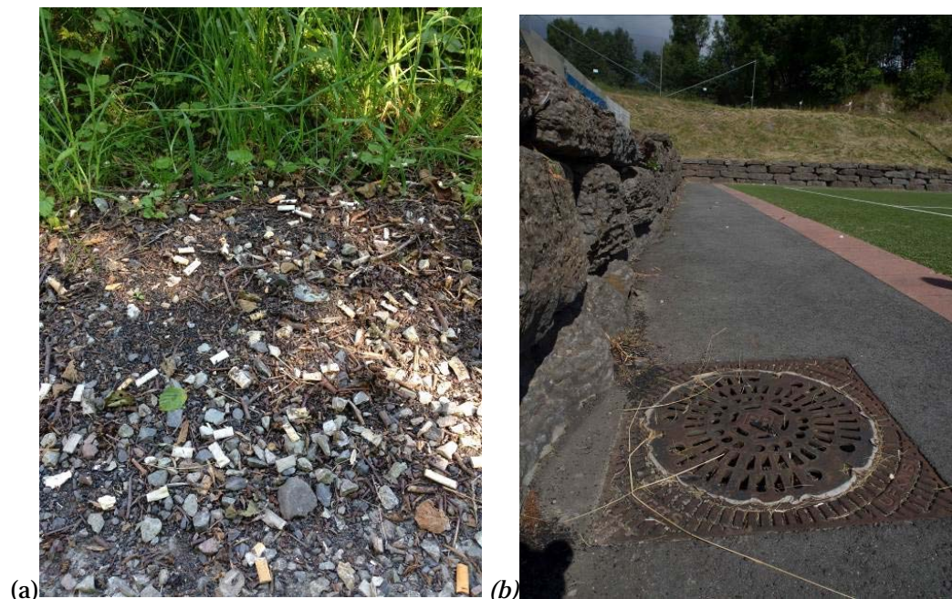
Figur 4. Synlige mengder granulat på sørsiden av banen (a), fiberduk er lagt inn i alle avløpskummer på banen (b).
