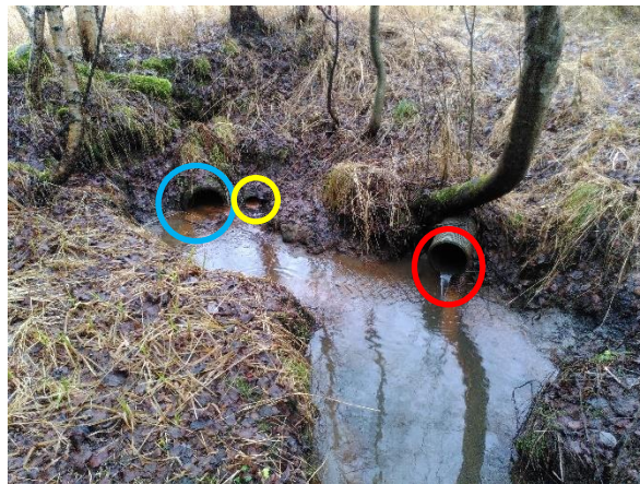
Bilde 44: Prøvetakingspunkt Nannestad 6 (rød sirkel - overvannsrør), Nannestad 7 (blå sirkel - utløp rør hovedbekkeløp) og Nannestad 8 (gul sirkel - eldre teglrør). Bildet er fra prøvetakingsrunde 5, 16.11.2020.
