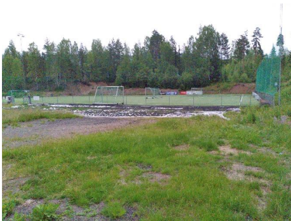
Bilde 25: Oversikt over 7-er banen sett fra parkeringsareal sør-vest for banen. Det ligger en duk i forlengelse av banen med mye granulater. Det er også spredt granulater utenfor selve duken. Bildet er fra prøvetakingsrunde 1, 23.6.2020
