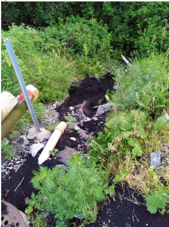
Bilde 57: Grunn kum (ned til venstre) og utløp fra denne (prøvepunkt Frogner 5). Det er svært mye granulater i erosjonsrenna ved forbindelse med utløpspunktet. Bildet er tatt ved prøvetakingsrunde 1, 23.6.2020.
