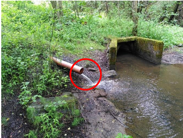
Bilde 17: Utløp av overvann (med retning fra banen) prøvepunkt Kurland 3 (rød-sirkel). Bildet viser også utløp av kulvert. Bildet er fra prøvetakingsrunde 1, 23.6.2020
