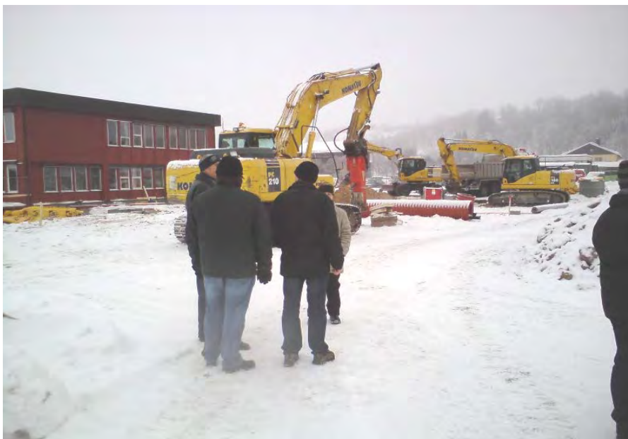
Figur 33. Pågående markarbeten för Verket i Röros, januari 2010
