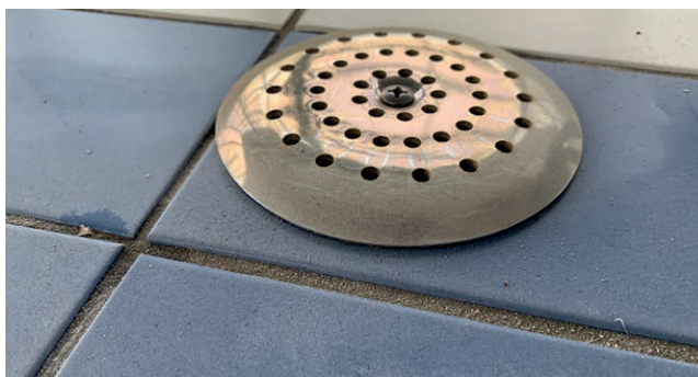
Figur 30: Sementbaserte fuger smuldrer bort med tiden og medfører nedtapping og driftsstans for refuging.
