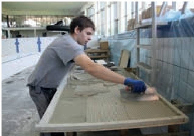
Figur 33: Ved dobbelliming benyttes utleggerbrett for påføring av lim på baksiden av flisen, enten jevnt avstrøket eller rillet opp med tannbrett. (Foto: NBKF)
