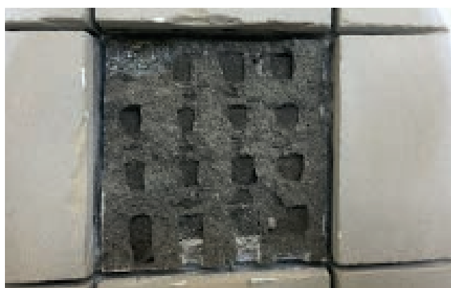
Figur 36: Eksempel på ikke tilfredsstillende limdekning.
