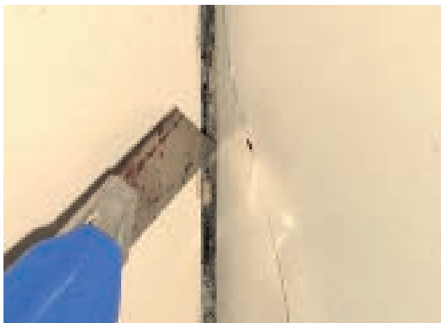
Figur 23: Knusning av flis eller bom kan opptre hvis der er rester av lim og stiv fugemasse i fugeåpningen.
