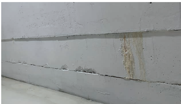
Figur 13 a og b: Typiske lekkasjesteder er ved materialskjøter og gjennomføringer.
