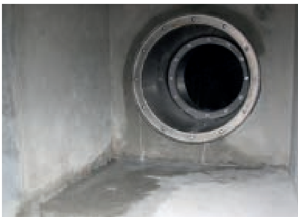
Figur 13 a og b: Typiske lekkasjesteder er ved materialskjøter og gjennomføringer.
