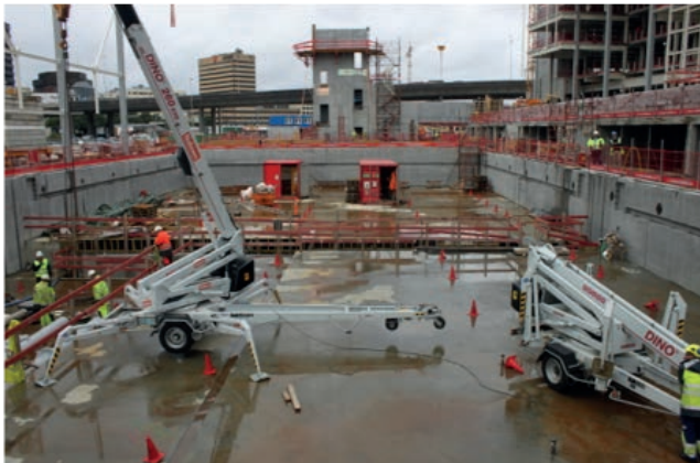
Figur 4: Til flislagte bassenganlegg inngår betongarealer som skal ha utforming og overflater som fungerer som underlag for fliser eller mosaikk. (Foto: NBKF)
