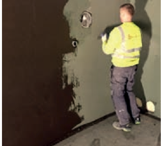
Figur 17: Sementbaserte, fleksible membraner trekkes på med brett.
