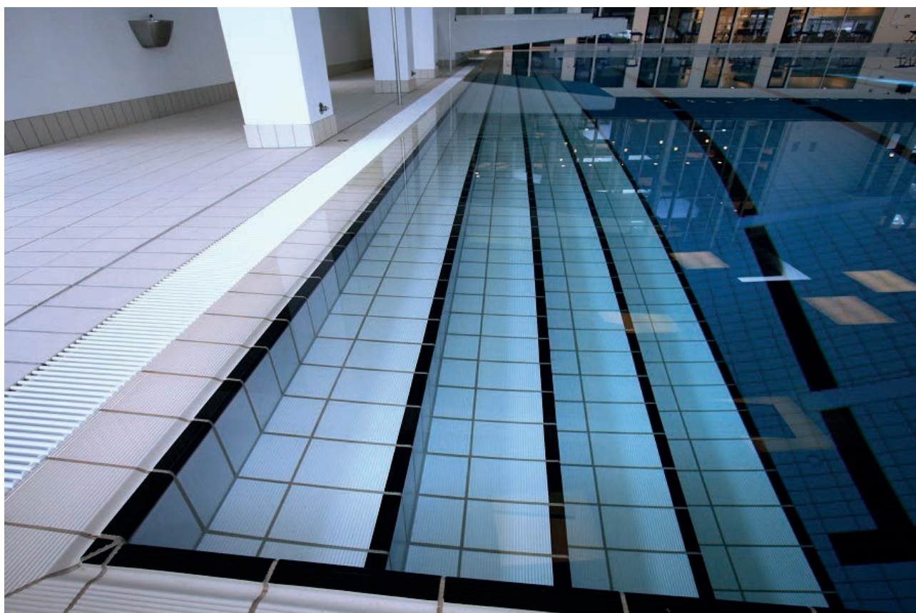
Bildet viser overgang på renne mot trapp ned i basseng. Merk kontrastmarkering på trinn. (ADO-senteret - Faglis / Schönox)
