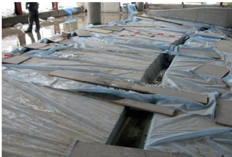
Figur 6: Tildekking med plast hindrer rask uttørking i overflaten. (Foto: NBKF)
