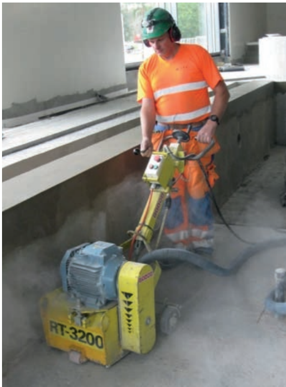
Figur 11: Det finnes ulike blastring-, frese- eller kuleslyngemaskiner som skaper en ru overflate og samtidig fjerner betongslam og smuss. (Foto: NBKF)
