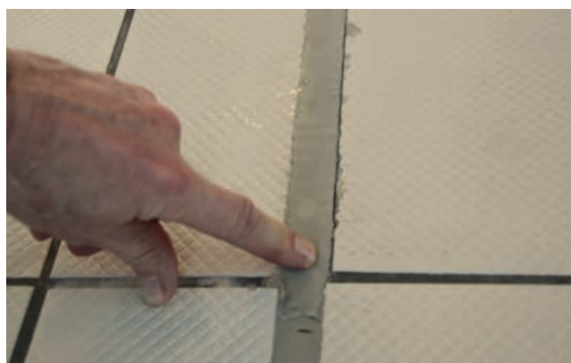
Figur 25: Elastiske fuger har et gjennomsnitt levetid på 4 - 6 år.
