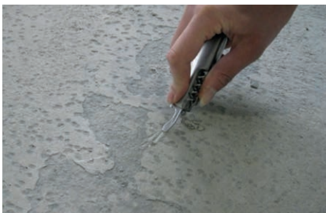
Figur 10: Sementhinne og annen forurensning må fjernes før limingen starter. (Foto NBKF)
