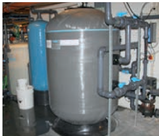
Figur 29: Beholder med marmorgranulat koblet i vannkretsen tilfører mineraler i vannet.
