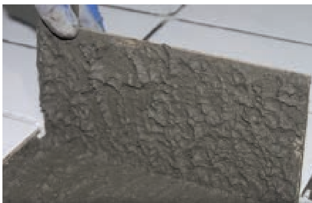
Figur 34: Jevnlige "slakteprøver" avdekker eventuelle utførelsesmangler.
