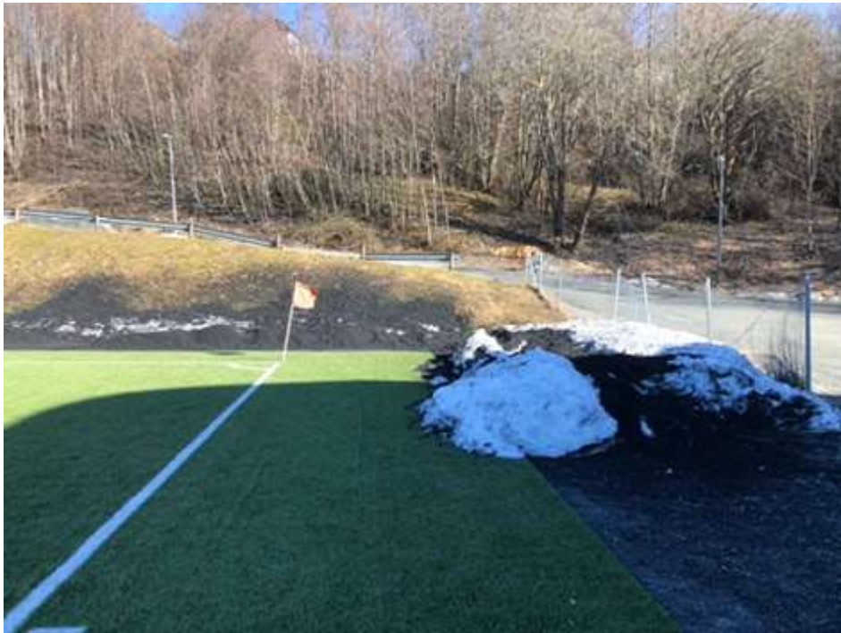
Figur 15: Spredning av gummigranulat utenfor banen (foto: Bjørn Aas)
