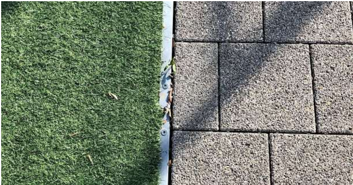
Figur 2: Forankring av kunstgressmatte uten innfyll for å forhindre forskyvning (foto: Bjørn Aas).
