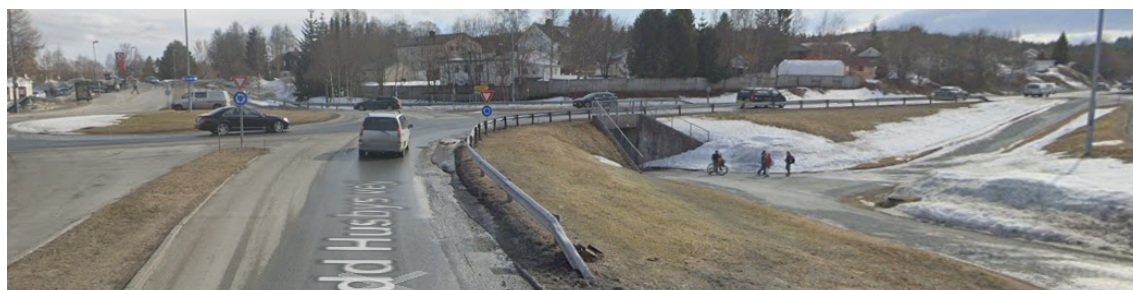
Figur 4: Under rundkjøringen ved Stavsetsenteret er det en kulvert. Anbefalingen er å utnytte denne for å redusere antall gående som krysser vegen. Dette er for å øke trafikksikkerheten og unngå kø for biltrafikk.
