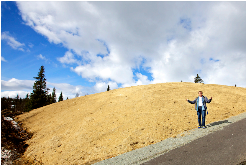
Figur 3-14: Snølageret på Beitostølen dekket av flis for lagring over sommer (Strande 2013)
