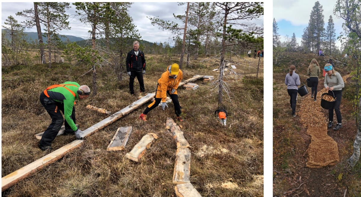
Figur 12: På rundløypen som ikke er universelt utformet er det lagt kokosnett overlatt med furufлис og klopper for å gjøre stien mer robust for økt ferdsel. Foto: Ingve Birkeland
