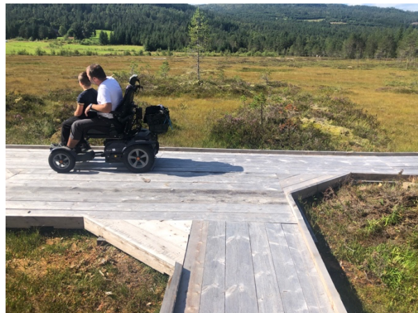
Figur 3: Rullestolbruker i vegkryss på rullestolvennlig kavlgveg. Foto: Anne Lise With Vullum.
