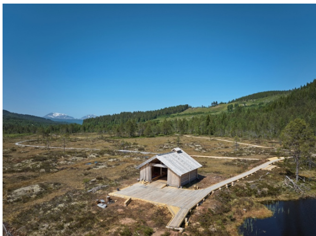
Figur 5: Luftfoto av hvilebu og kavlveg under konstruksjon. Foto: Anne Lise With Vullum
