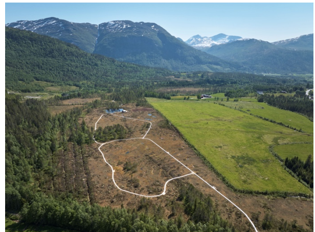
Figur 1: Luftfoto som gir oversikt over kavlveg-anlegget. Foto: Lediard Foto.
